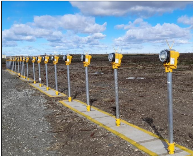
Mounting ALS lights on aluminium poles and frangible couplings on a 300-meter bar
