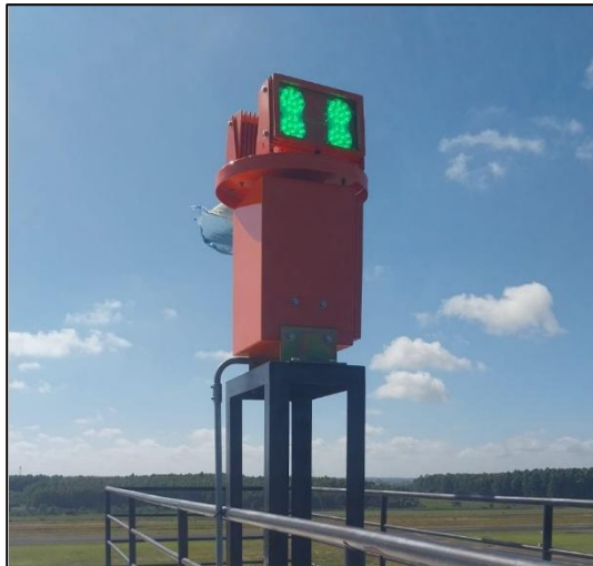
Faro de Aeródromo
