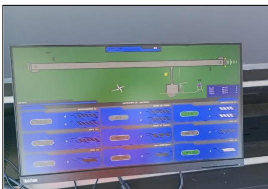
Instalación de equipos del Sistema de control de Balizamiento
