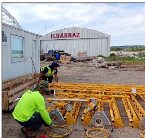
Preparación de mástiles para luces ALS
