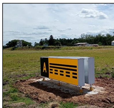
Instalación de letreros
