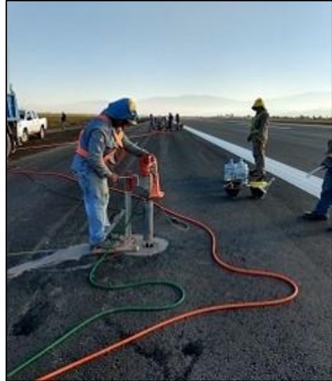
Perforación de pavimento para colocación de luces embotradas
