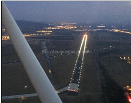
Vista Aérea de Luces de Pista
