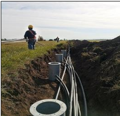
Instalación de bases L-867 y Acometidas primarias
