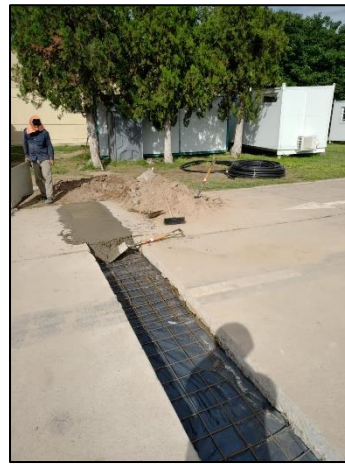
Canalización a cielo abierto en vialidad
