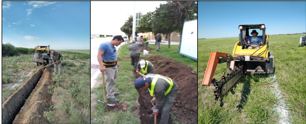
Zanjeado a máquina y manuales para acometidas primarias
