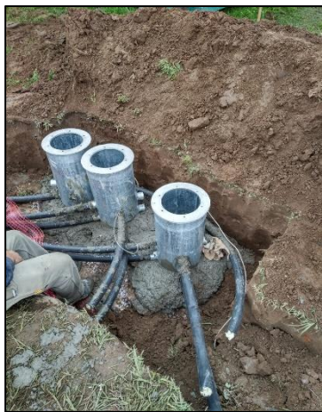
Instalación de bases L-867
