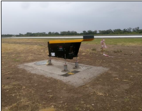
Instalación de luz de PAPI (Led)
