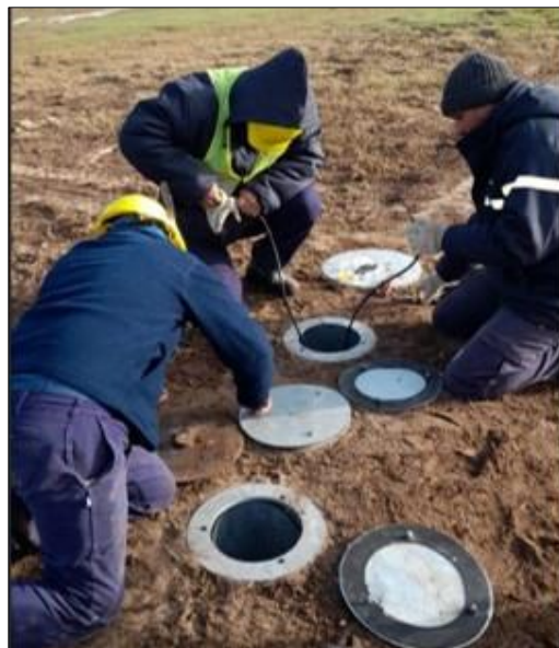
Colocación de conectores primarios
