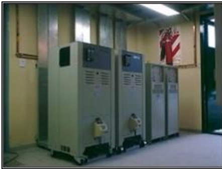
SET de Balizamiento
