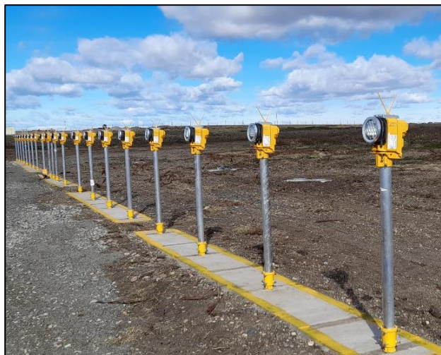
Montaje de luces ALS sobre postes de aluminio y cuplas franjibles en barra de 300 metros
