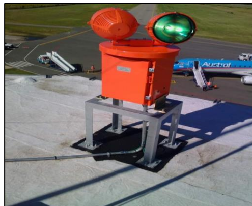
Faro de Aeródromo instalado
