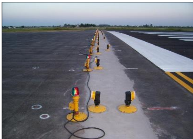
Luces de umbral y fin de pista
