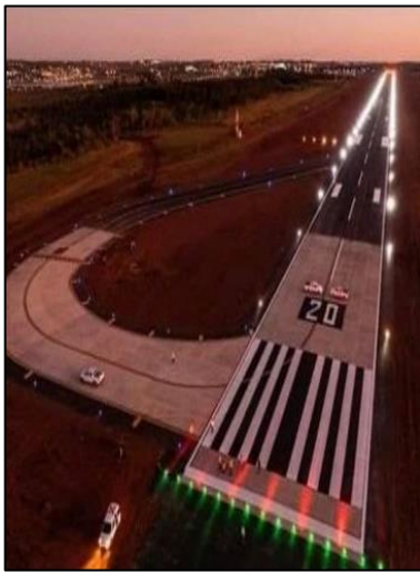
Balizamiento de Pista
