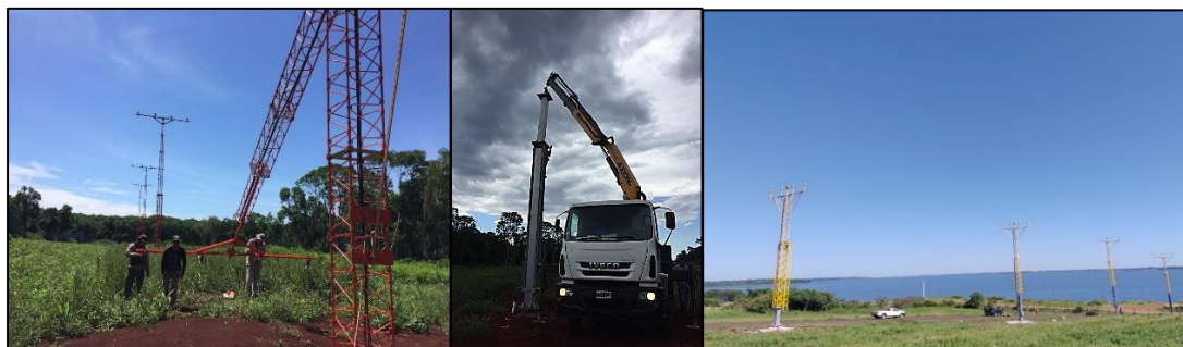
Instalación de mástiles para luces de aproximación y flash
