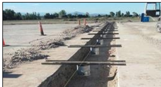
Instalación y nivelación de Bases L-868 para luces de umbral
