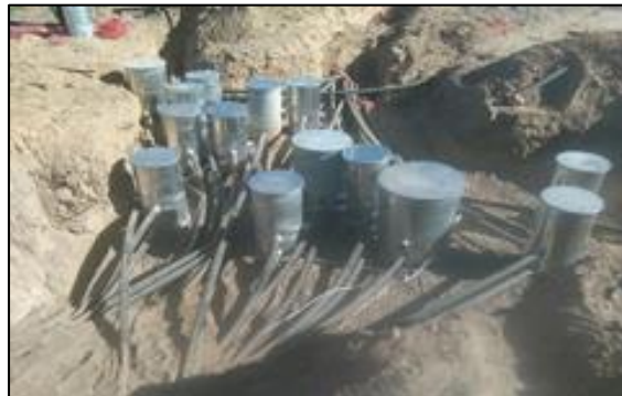
Instalación de baterías de bases L-867
