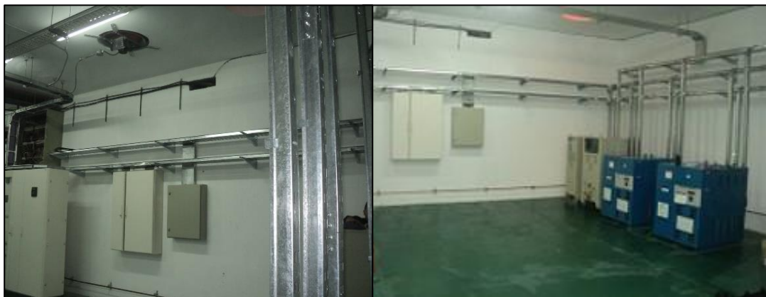
Armado de nueva SET balizamiento
