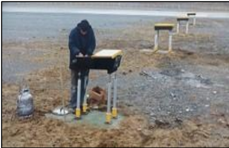
Instalación de Luces PAPI
