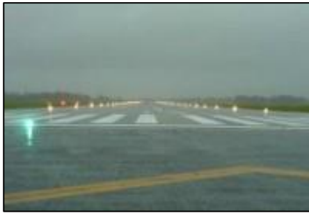
Balizamiento de pista
