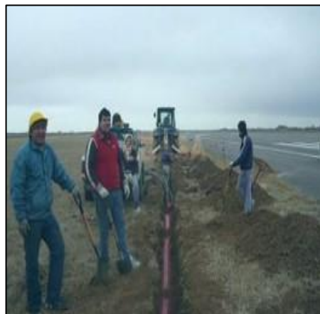
Canalizaciones de acometidas circuitos primarios
