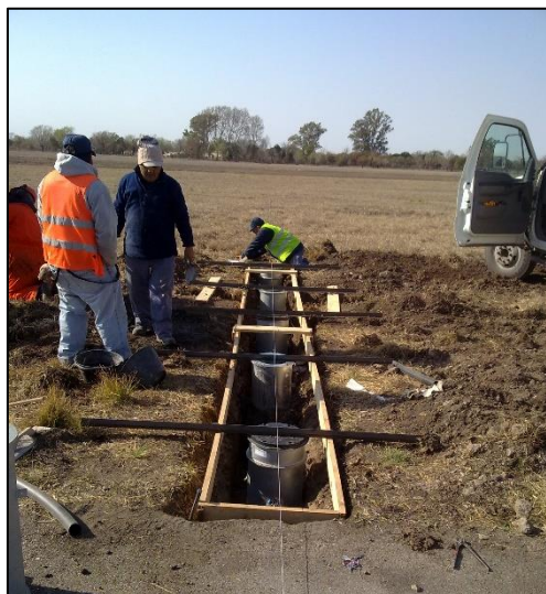
Colocación de bases L-867 y elaboración de bases de hormigón PAPI base
