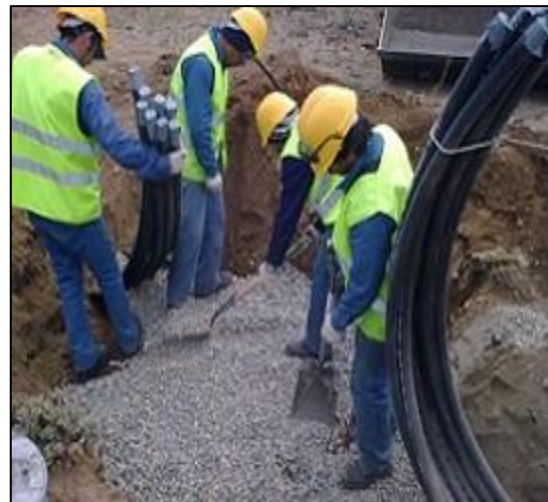
elaboración de base de cámara para circuitos de balizamiento
