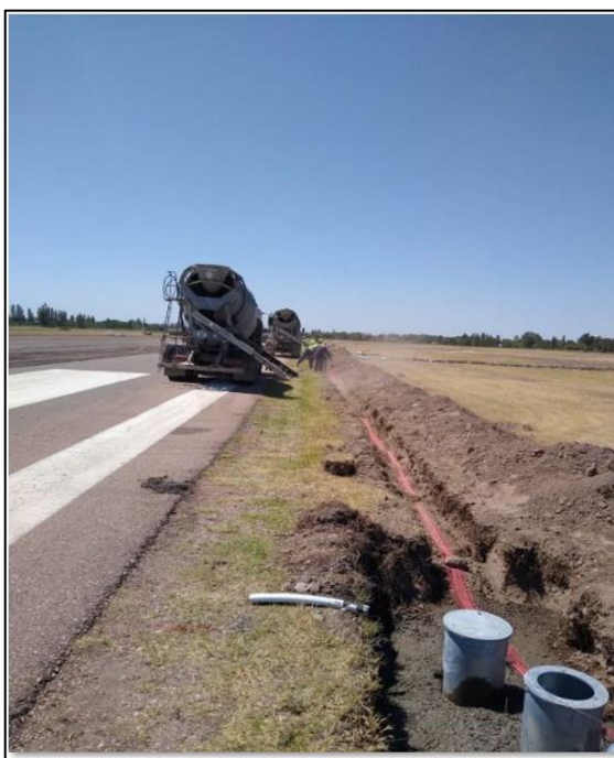
Colocación de Hormigón sobre caños de acometidas primarias
