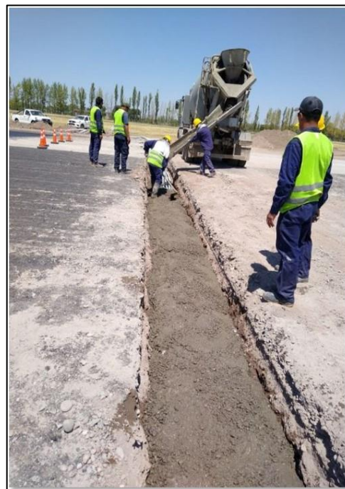
Colocación de Hormigón sobre caños de acometidas en cruce de umbral
