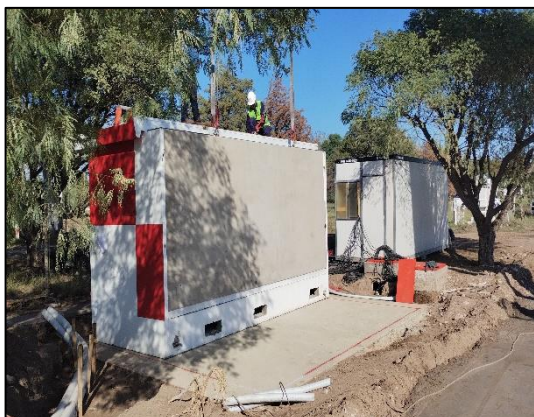
Instalación de SET Balizamiento
