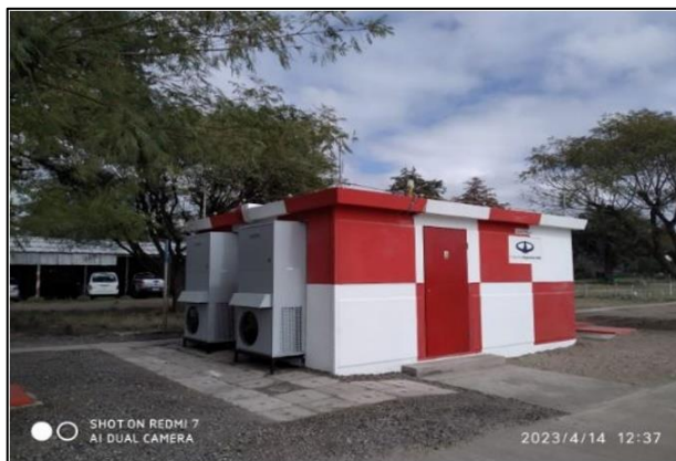
SET Balizamiento instalada
