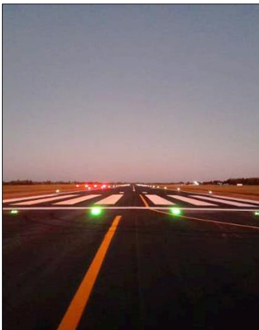
Balizamiento de pista
