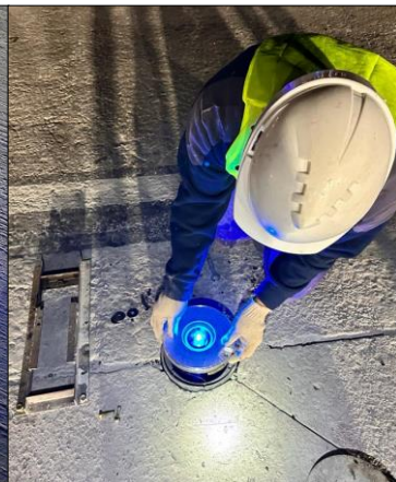
Colocación de balizas empotradas
