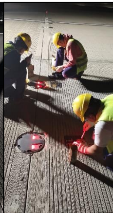
Colocación de balizas empotradas
