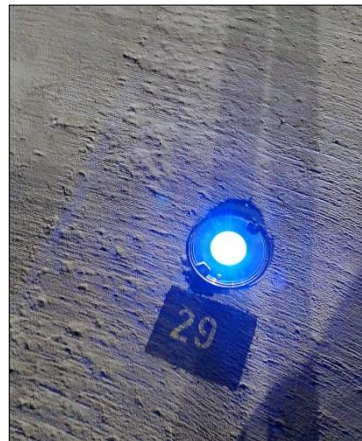
Colocación de balizas empotradas
