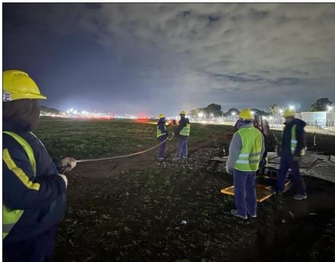
Tendido primario durante NOTAM
