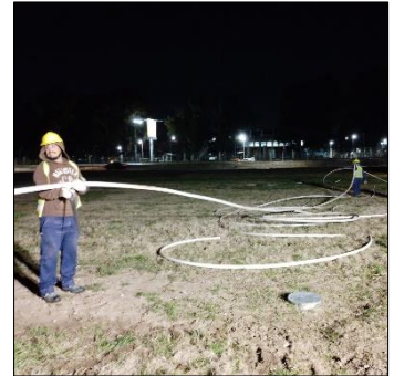
Colocación de caño para cableado primario
