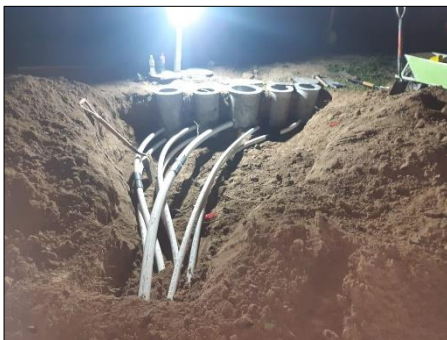
Colocación de bases L-867
