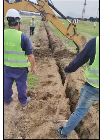
Zanjeo y preparación de terreno para cableado de MT y BT
