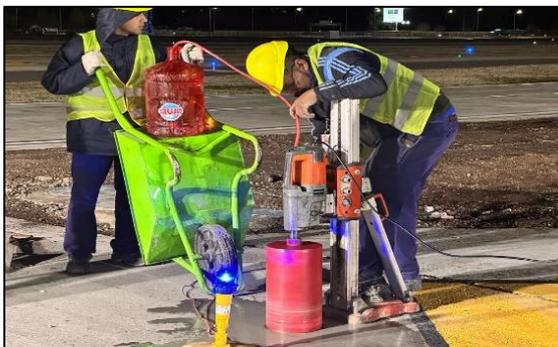
*Perforación de pavimento para instalación de balizas empotradas*
