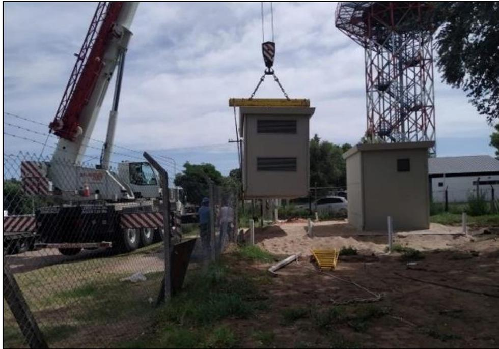
*Instalación de edificios premoldeados para Subestación de balizamiento*
