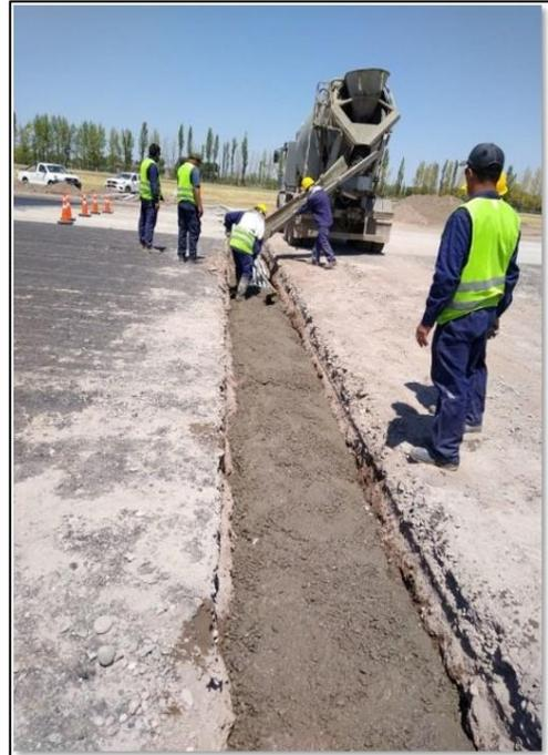
*Colocación de Hormigón sobre caños de acometidas en cruce de umbral*
