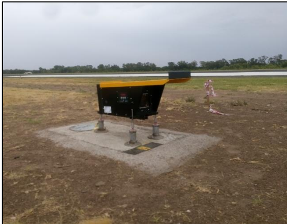
Instalación de luz de PAPI (Led)
