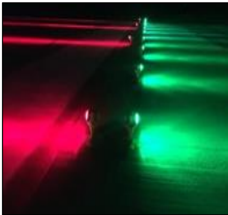
Luces de umbral y fin de pista
