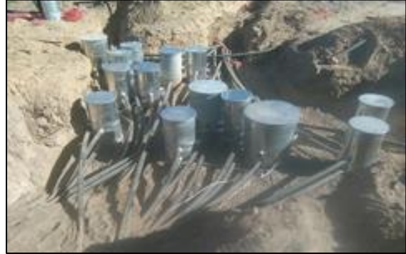
Instalación de baterías de bases L-867
