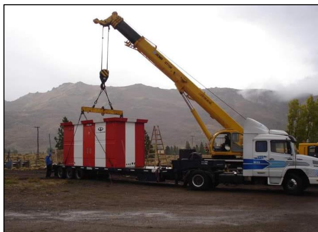
Emplazamiento de edificio Premoldeado.
