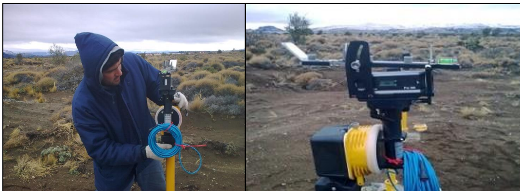
Uso de inclinómetro Calibración de Luces de Aproximación
