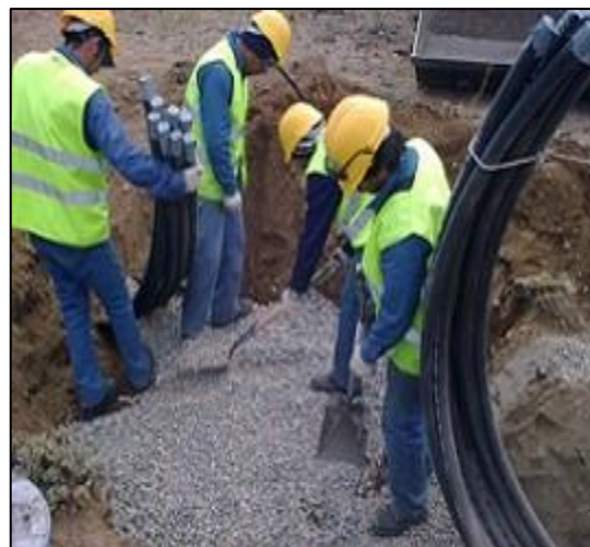
elaboración de base de cámara para circuitos de balizamiento
