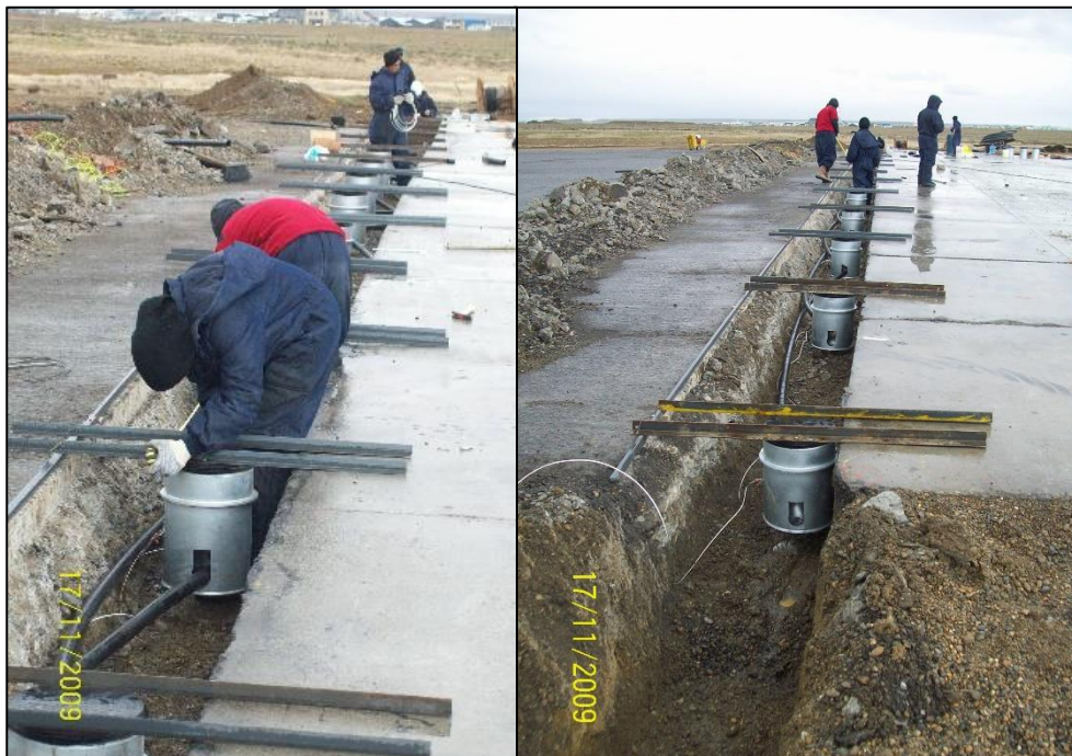
Instalación de bases L-868 para luces de umbral
