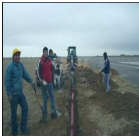
Canalizaciones de acometidas circuitos primarios
