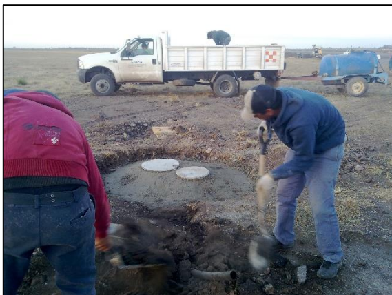
Elaboración de conos de protección mecánica para batería de bases L-867
