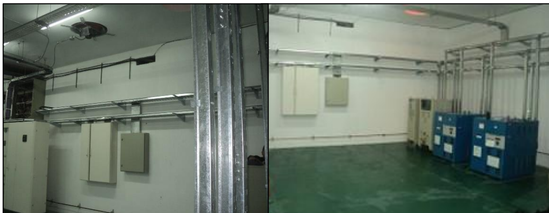
Armado de nueva SET balizamiento
