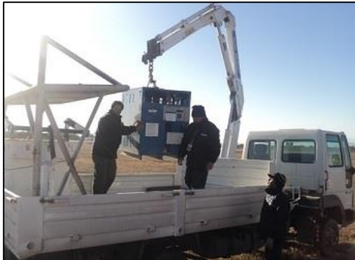
Traslado de RCC a nueva SET balizamiento
