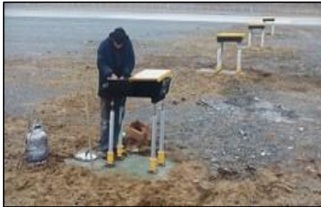
Instalación de Luces PAPI
