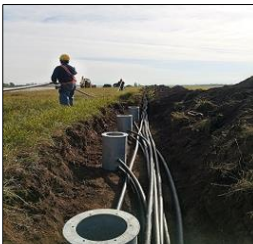
Instalación de bases L-867 y Acometidas primarias
