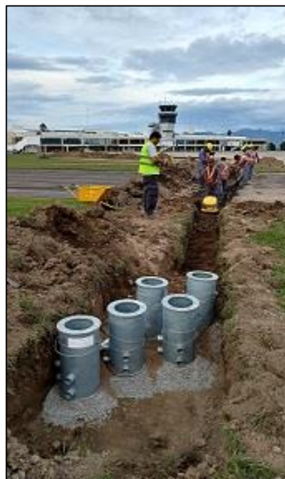
Zanqueo e instalación de bases L-867 para acometer luces de umbral
