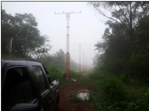
Instalación de luces de Aproximación sobre mástiles
